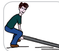
* Bloquer l'extrémité de la poutre pour l'empêcher de glisser
