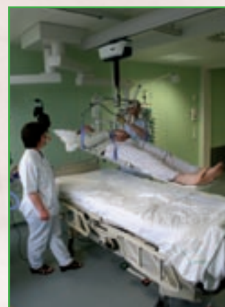
Rail fixé au plafond et aide au levage du patient
